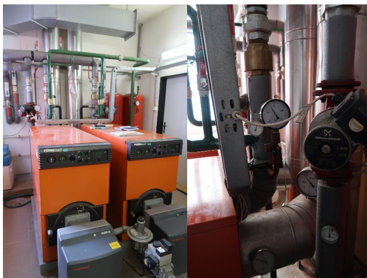
Obrázok č.15 Pôvodná plynová kotolňa
