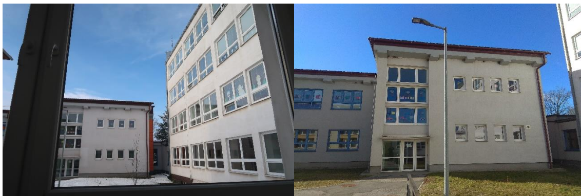
Obrázok č.3 Pohľad na objekt - východný pavilón B
