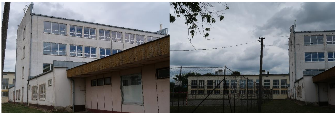
Obrázok č.13 Pohľad na objekt - severovýchodný pavilón C, spojovacia chodba
