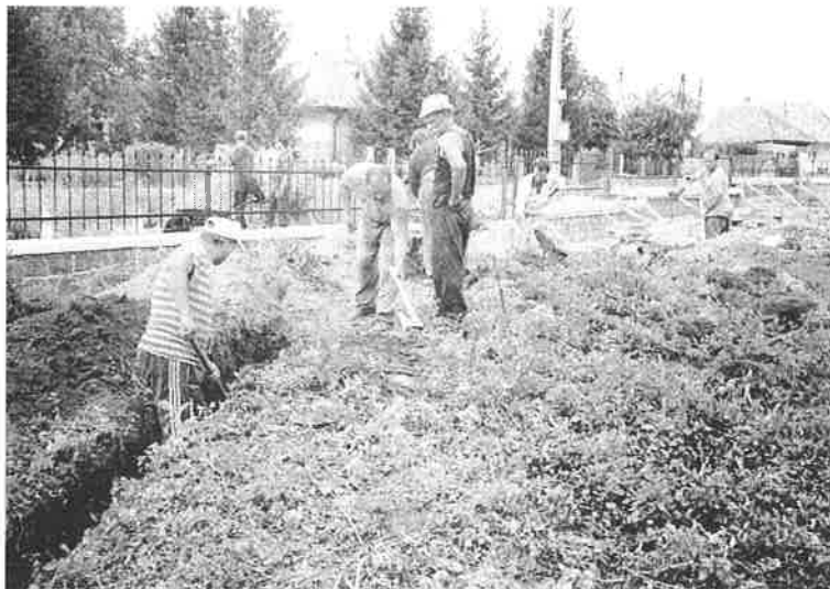
Najprv bolo potrebné uložiť do zeme elektrické rozvody a rozvod vody.
