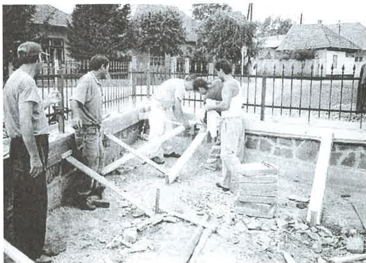
Práce na výstavbe parku prof. Hlaváča.
