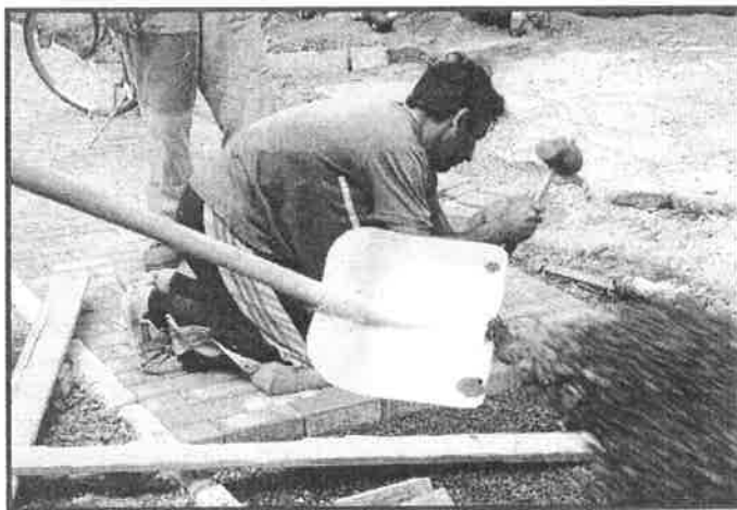
Najlepšiu pokladač zámkovú dlažbu a zároveň najlepšiu pracovník VPP 2001 – Marcel Zupko
