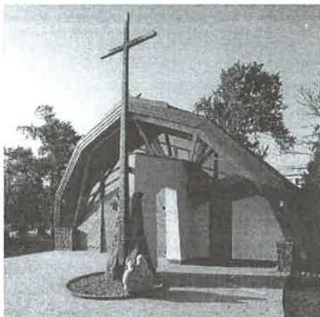
Čelný pohľad na Dom smútku.
