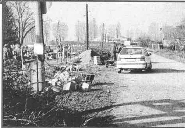
Práce na rekonštrukcii cintorínov v Buziciach a Bernátovciach.
