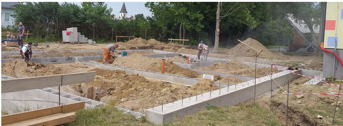
Práce na prístavbe k zdravotnému stredisku
