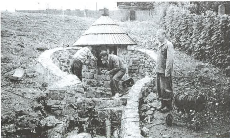
Posledné úpravy na novopostavenej studničke na Čorgove v časti Buzice
