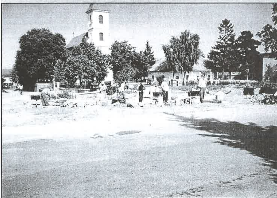
Práce pri výstavbe oplotenia Parku prof. Hlaváča.
